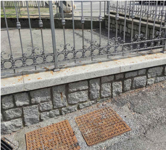
Particolare muratura esistente. Il muro di progetto dovrà essere uniforme per tipo di posa e materiali a quanto già in essere.
